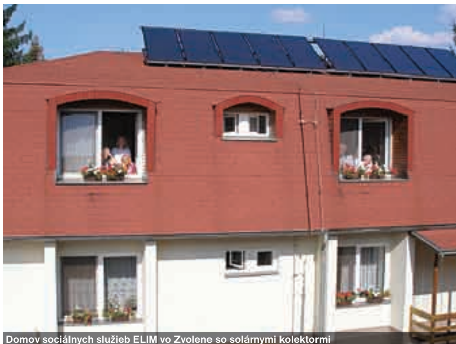
Domov sociálnych služieb ELIM vo Zvolene so solárnymi kolektormi
