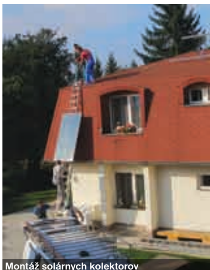
Montáž solárnych kolektorov
